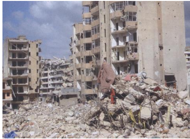
شكل (4) مخلفات عملية الهدم تشكل عبا على البيئة لصعوبة التخلص منها المصدر (8)
